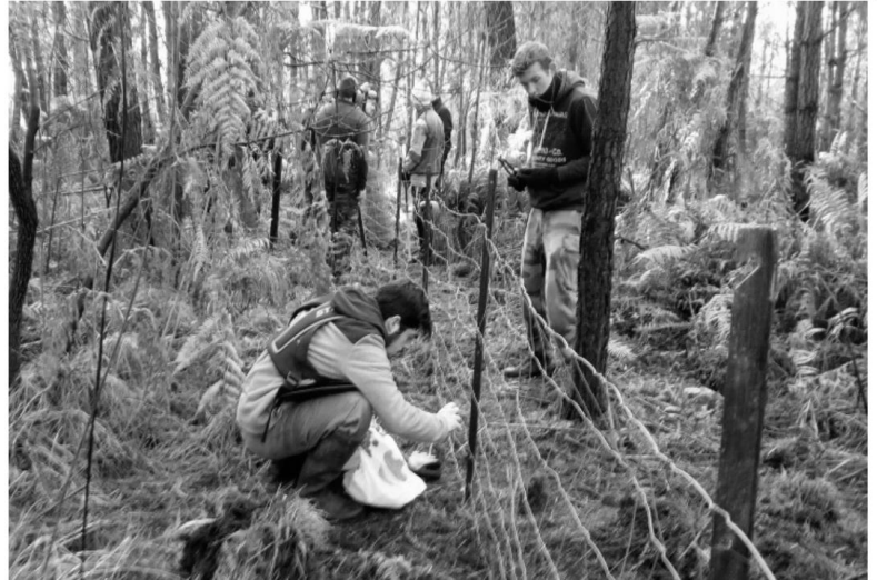
Pose de la clôture à moutons par des lycéens
