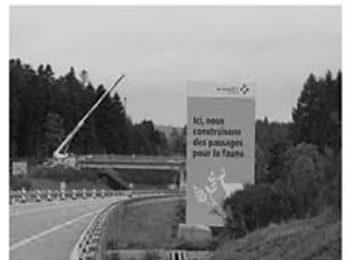
Construction d'un passage à faune sur une autoroute
