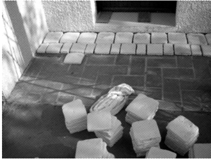
Placage en recouvrement de la terrasse existante
