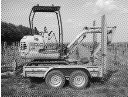
Minipelle utilisée sur le chantier et sa remorque
