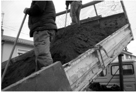
Déchargement de la terre
