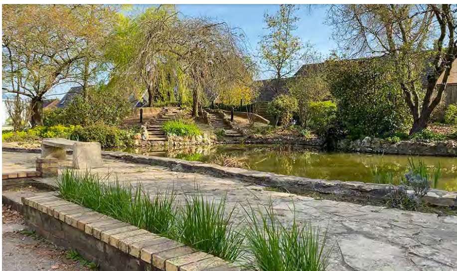
Construction paysagère sur le site du CFA-CFPPA Horti-Pôle d'Évreux
